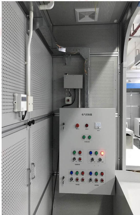
深圳第二高级技工学校
